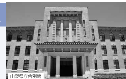
山梨県庁舎別館
