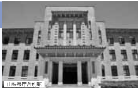
山梨県庁舎別館
