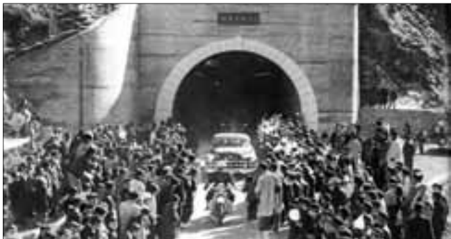
新笹子トンネル開通
