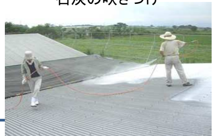
石灰の吹きつけ
