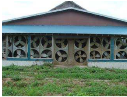
牛舎壁面の換気扇
