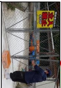
フェンス設置
