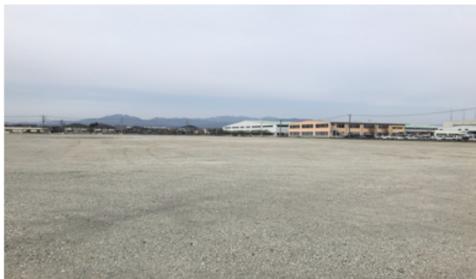
平成31年3月更地化完了
