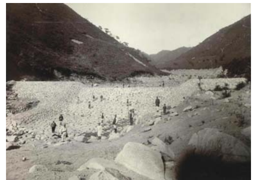
写真-2 完成状況(七号堰堤)
