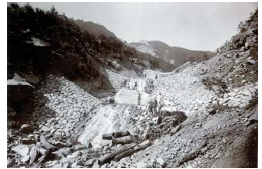
写真―4 完成状況
