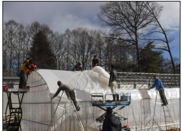
温室ハウスビニール張り
