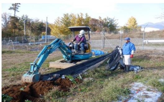
バックホー作業
