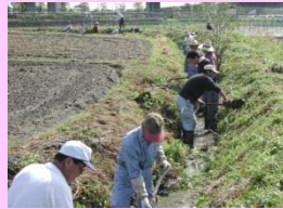
■ 水路の保全管理
