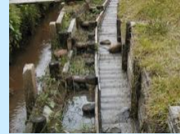
■ 水田魚道の設置
