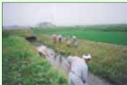
水路の泥上げ
