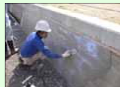
水路の補修・更新
