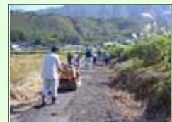
砂利舗装を アスファルト舗装へ
