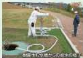
耐震性貯水塔からの取水の様子
