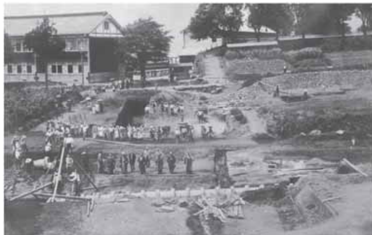
●昭和6年 月見が池施工状況風景
