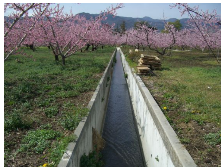
大雨時には水路から溢水していたが、水路が整備され排水能力が向上した
