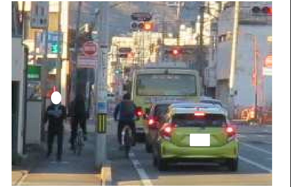
【写真②】 現道の状況 路肩・歩道が狭く、危険な状況
