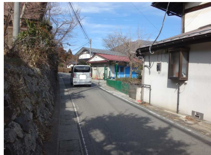
②幅員が狭く歩道もない状況 (車両のすれ違い不可)
