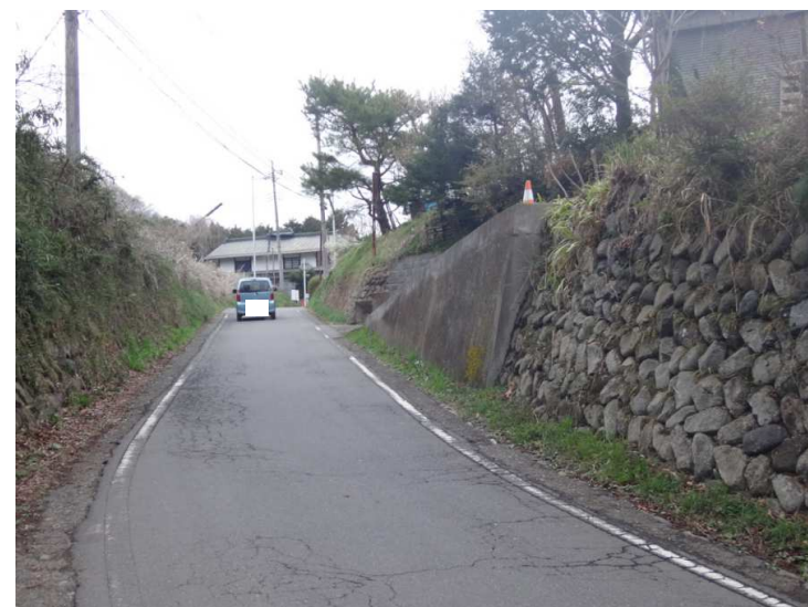
④幅員が狭く歩道もない状況 (車両のすれ違い不可)
