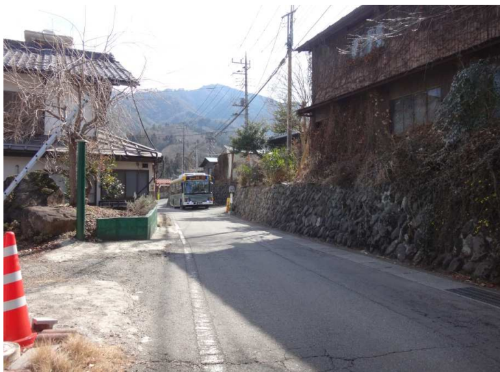
①幅員が狭く歩道もない状況 (車両のすれ違い不可)
