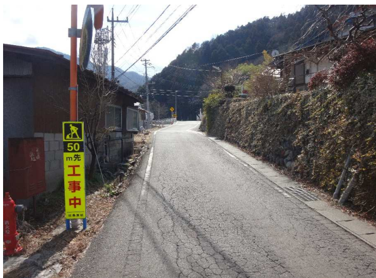
③幅員が狭く歩道もない状況 (車両のすれ違い不可)
