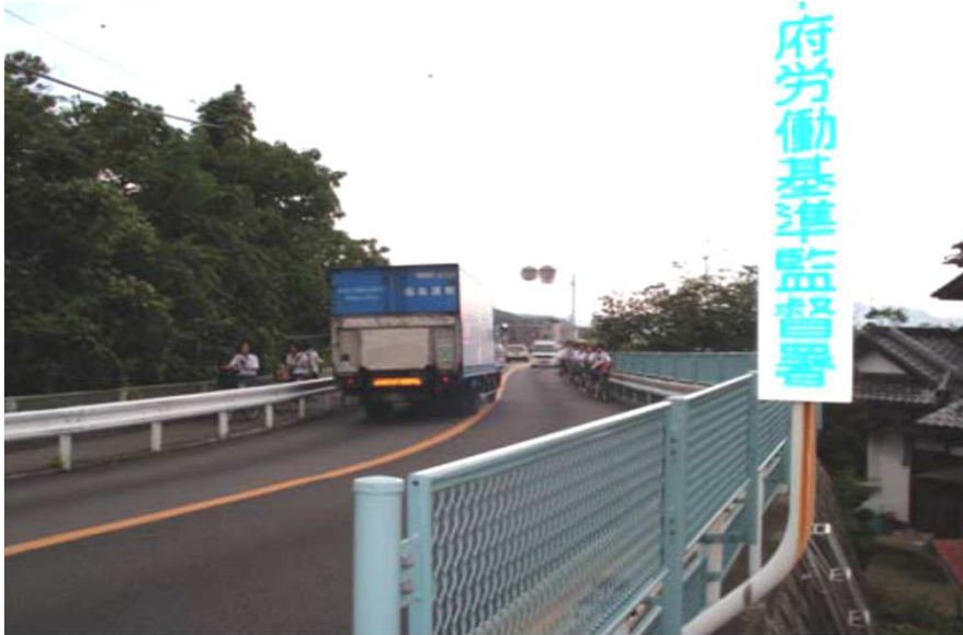
③幅員が狭く、車両が対向車線にはみ出している
