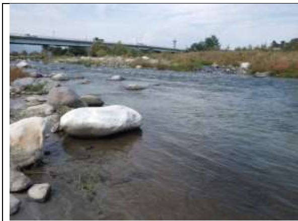
釜無川上流部: 船山橋
