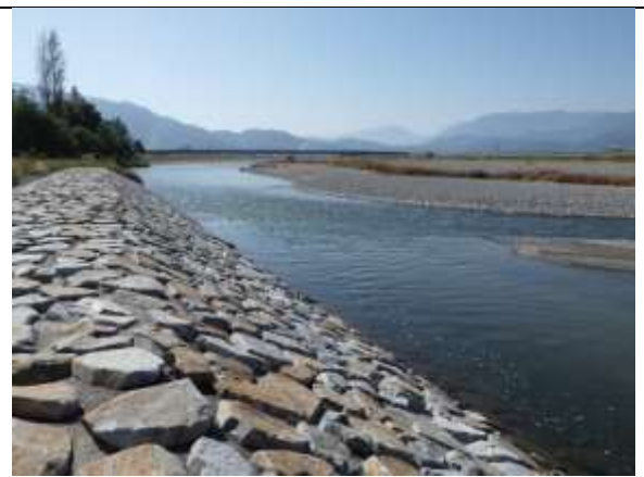
釜無川下流部: 浅原橋
