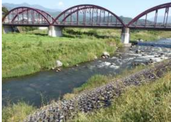
笛吹川上流部: 亀甲橋
