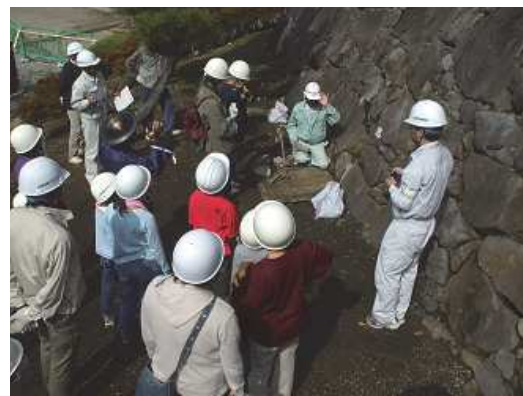
石垣補修工事の見学会
