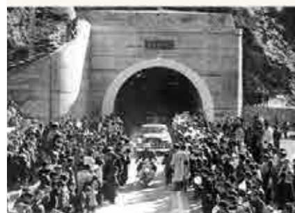
新笹子トンネル開通
