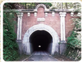
旧笹子トンネル
