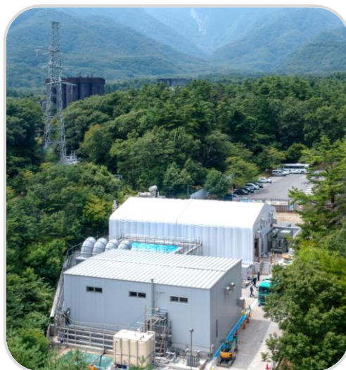
カナデビア:水電解装置 モジュール連結式 6MW
