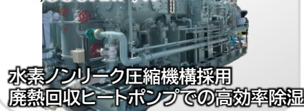
加地テック 水素除湿圧縮装置 1,800Nm 3 /h
