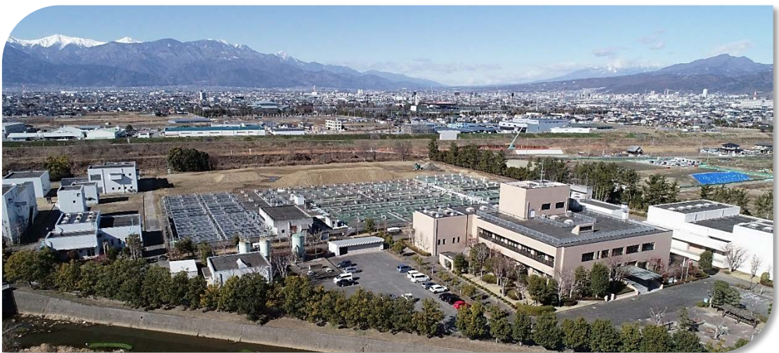
峡東浄化センター
