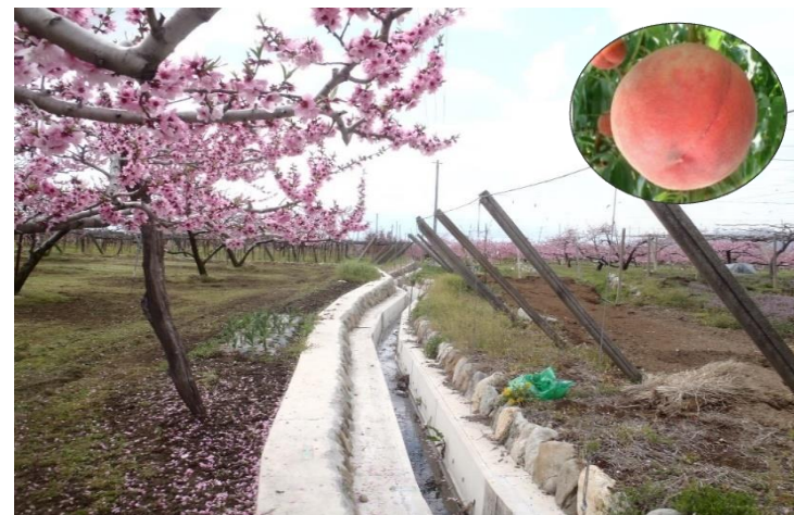
完成後 水路改修による排水改良や表土の流出防止により、営農条件が改善され、農作物の品質が向上した。 既設の石は土留めに利用するなど、景観にも配慮した整備が行われている。
