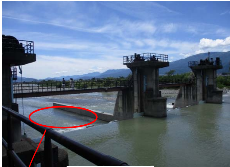
① 高岩頭首工の全景
