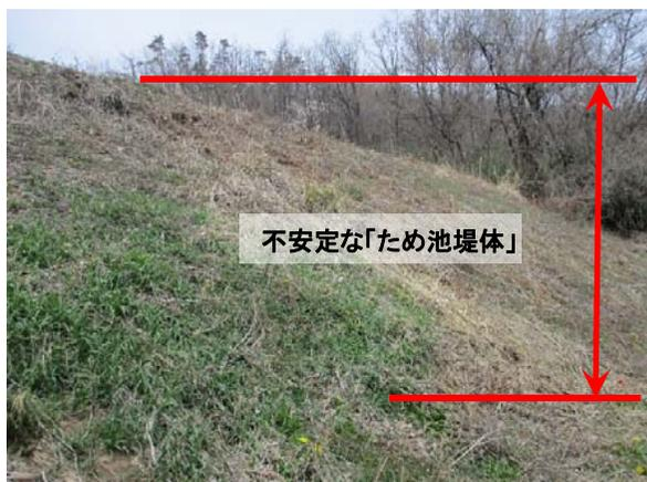
③ 堤体の安定性が確保されておらず地震時に堤体が決壊する危険がある。
