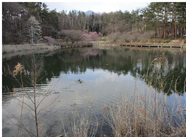
① 井詰原ため池 全景 安全率(地震時) 0.78 \leq 1.20 (基準値) 貯水量 34,000m 3 , 堤高 H=8.6m
