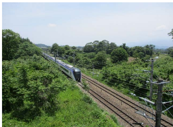
③ ため池下流には鉄道があり、大型地震の際には甚大な被害のおそれがある。
