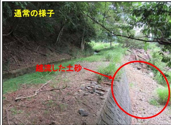
水路に土砂が混入した事により溢水した状況 (H29.10 台風21号)
