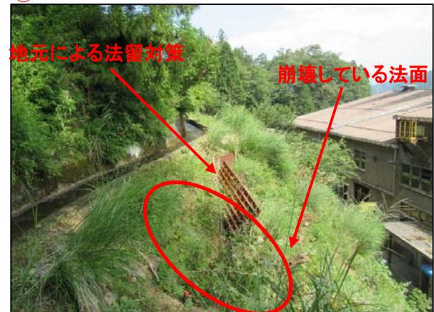
現場の法面状況地元では被災の度に人力により懸命な対応を行っている。
