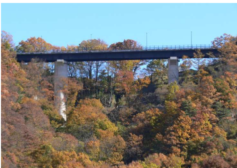
夏目橋（平成20年11月撮影）
