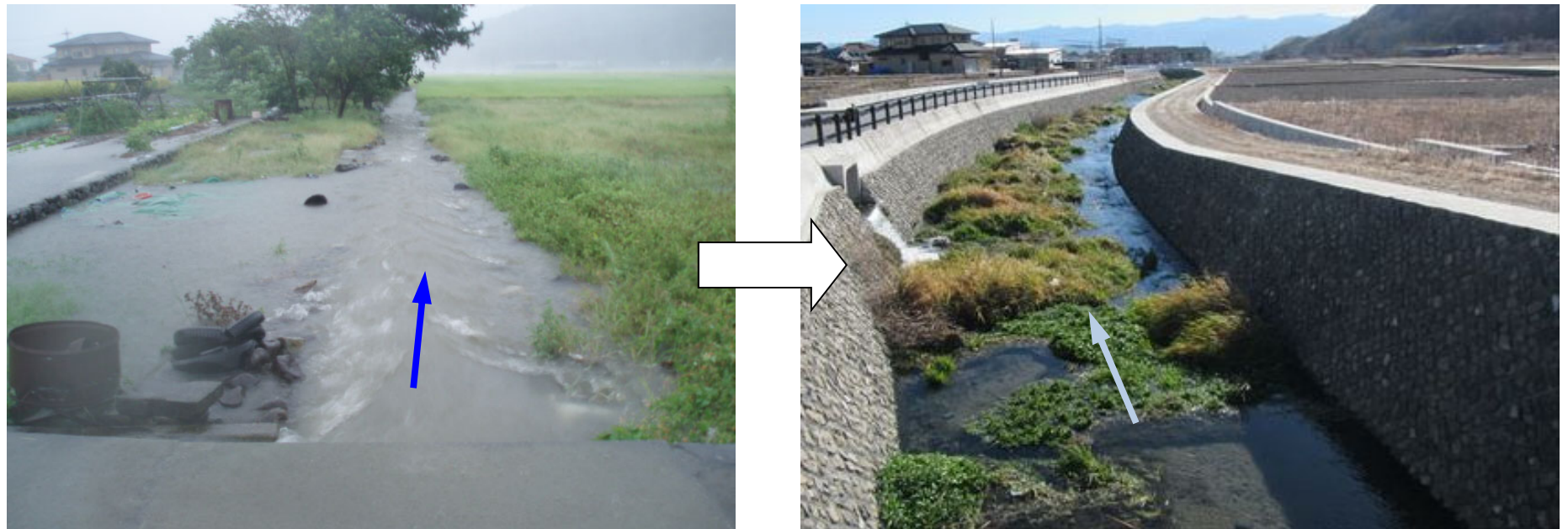
写真⑥ バイパス起点上流付近 左：出水状況（改修前） → 右：現況河道（改修後）
