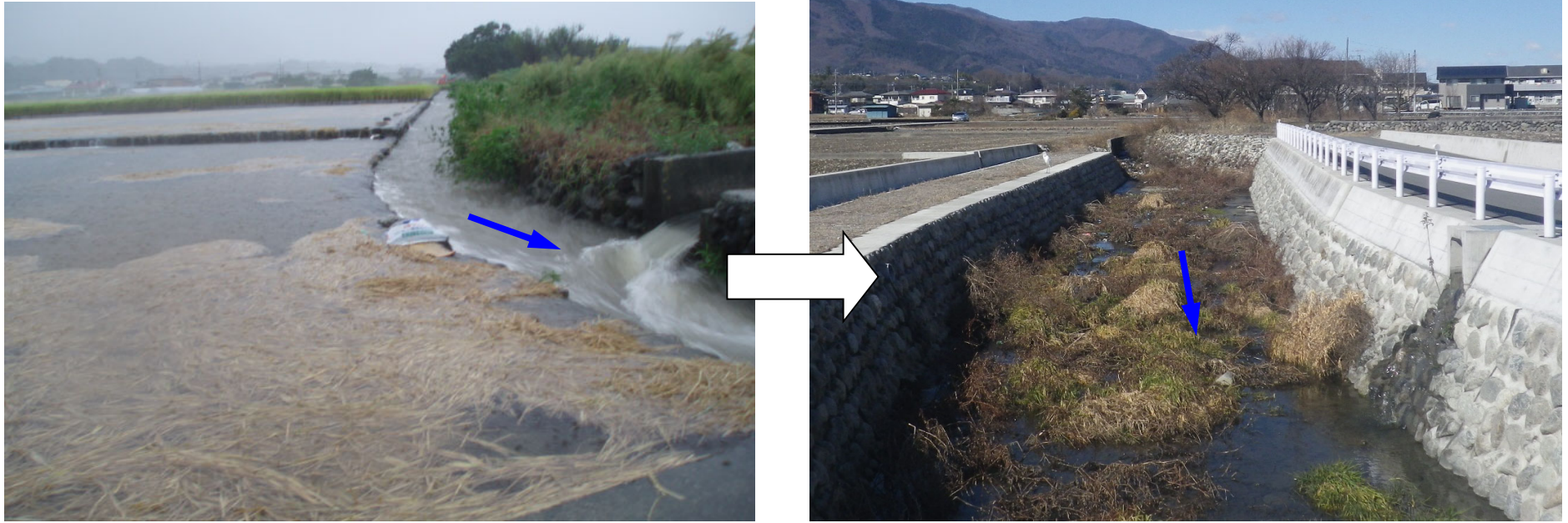
写真⑤ バイパス起点付近 左：出水状況（改修前） → 右：現況河道（改修後）
