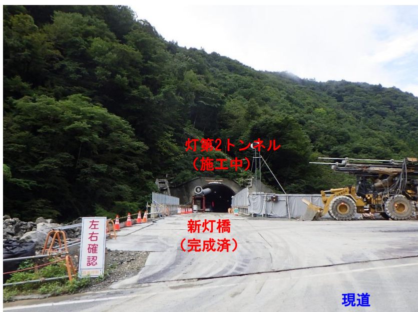
⑦ 進捗状況(新灯橋～灯第2トンネル坑口付近)
