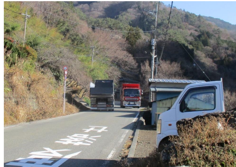
④ 幅員の不足 すれ違い困難な状況
