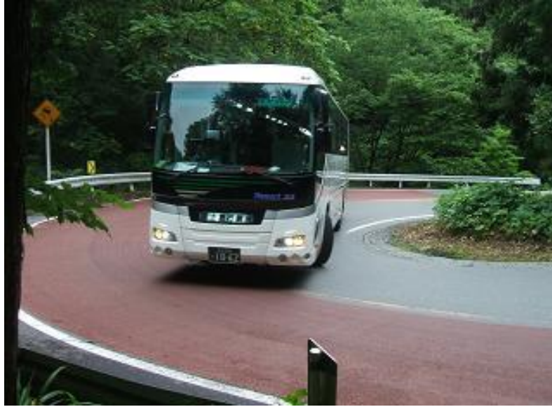
① カーブ半径の不足 反対車線にはみ出す大型車
