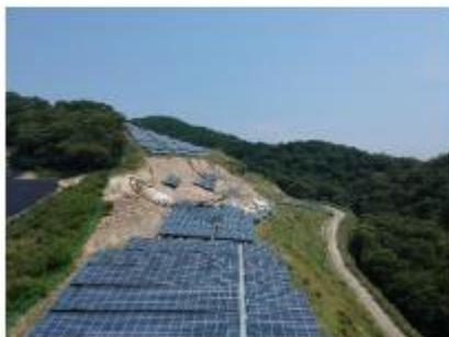
■ 傾斜地の崩壊が発生したため、法肩部分の架台が流出した事例
