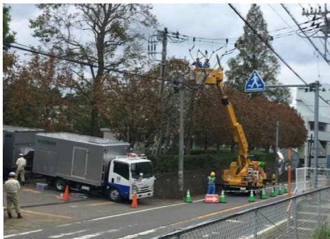
発電車の接続作業
