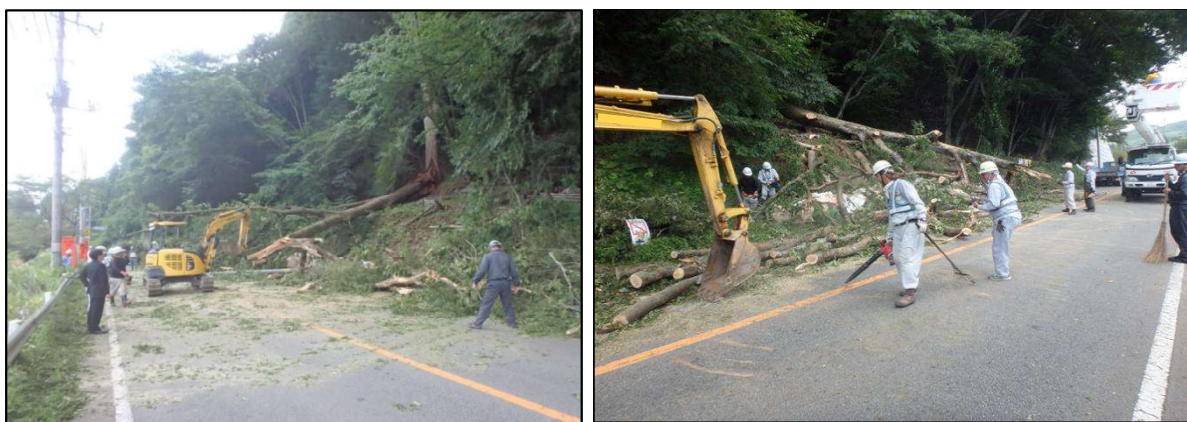
写真3_復旧作業における道路管理者(県)と東京電力PGの連携 (山梨県)
