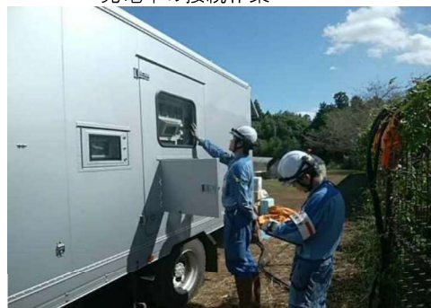
接続後の運転監視
