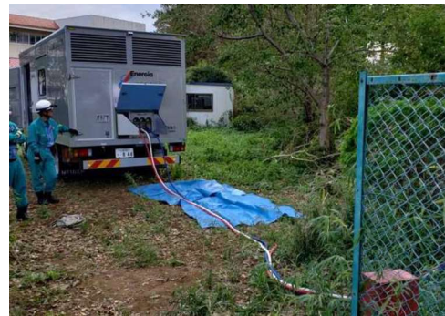
送電前の受電側の主任技術者による立会確認
