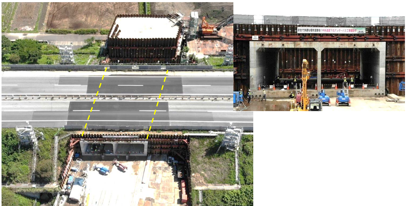
現場全景（左：南側上空から撮影・右：貫通状況）
