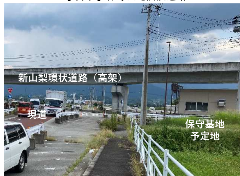
【写真B】 保守基地隣接道路
