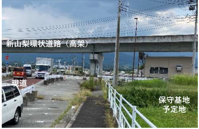
【写真B】 現道交差部 (新山梨環状道路×市道)
