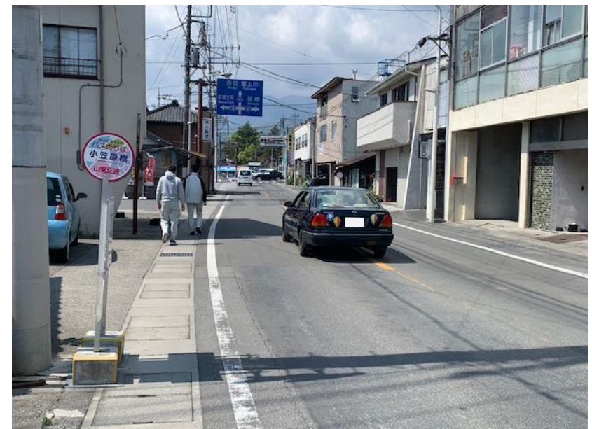
④歩道の未整備状況
