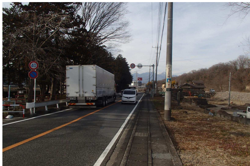
幅の狭い歩道の状況
