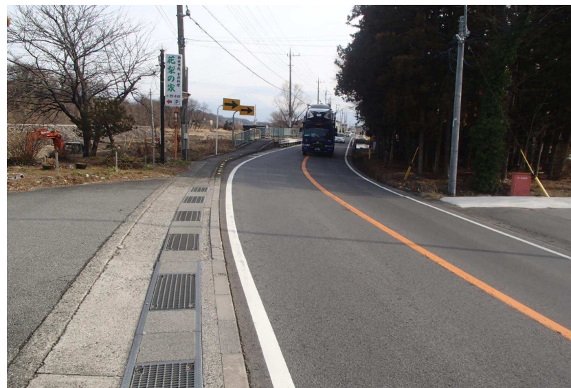
カーブがきつく幅員が狭い状況
