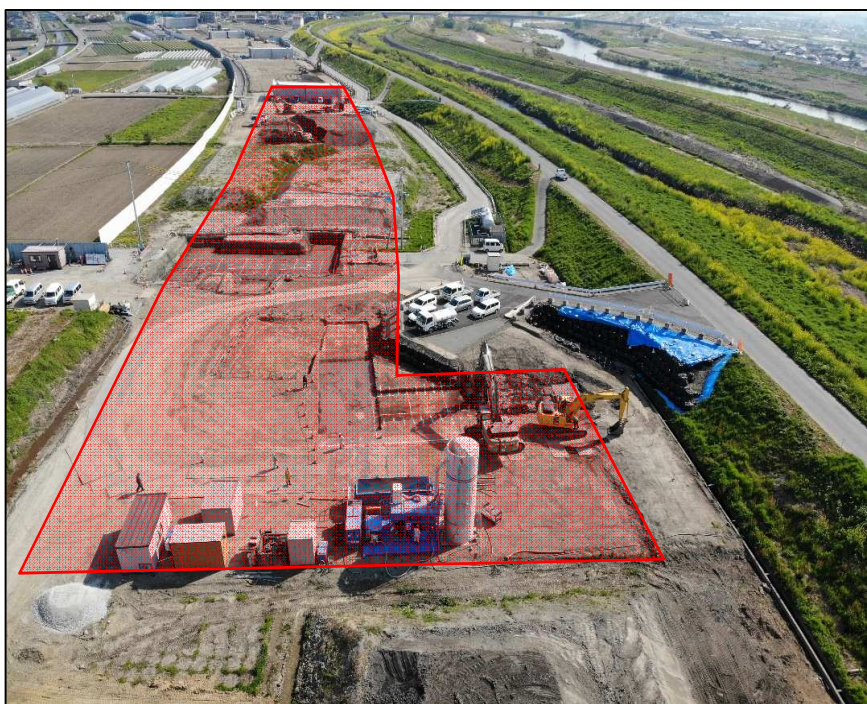
【 上空からドローンにて現場を撮影 】
