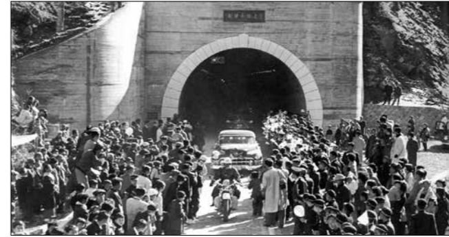
新笹子トンネル開通
