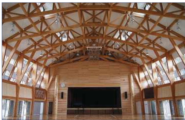
【トラス構造を用いた事例】
