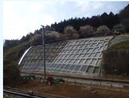
JR中央本線の復旧状況
