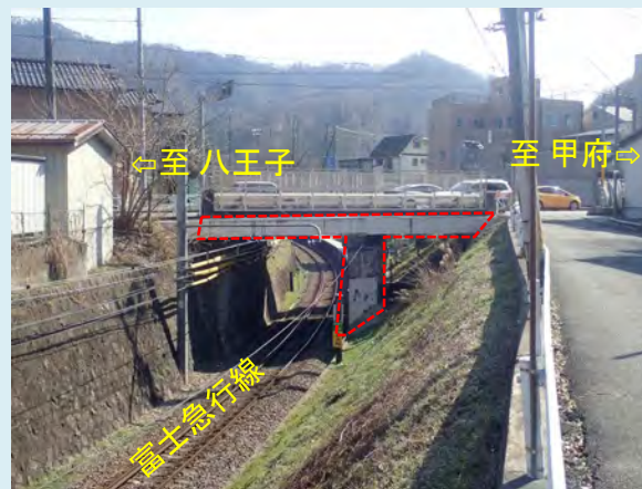
てんのう ② 天王橋 【橋梁補修】 主桁補修、橋脚補修等
