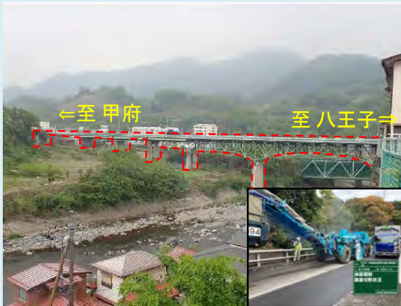
おおつきばし ① 大月橋 【橋梁補修】 構造物補修、舗装補修等
