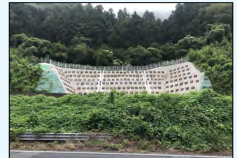
中央自動車道 小仏地区の復旧状況
