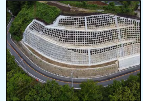
国道413号道路災害防除工事の施工後
