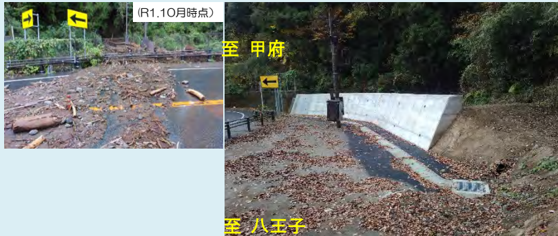
さがみはらしみどりくちぎら ① 相模原市緑区千木良 重力式擁壁による復旧完了
