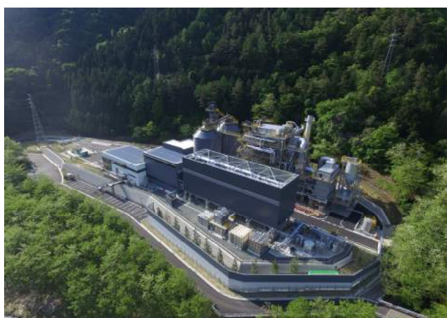
木質バイオマス発電所（大月市内）
