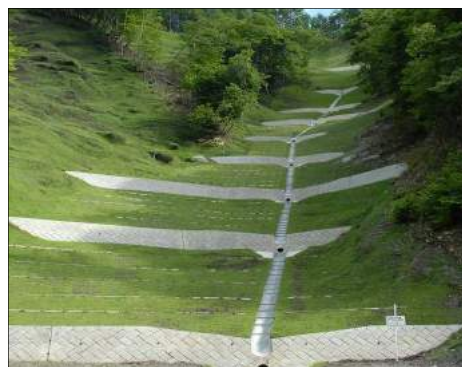
山腹工による崩壊地の復旧状況
