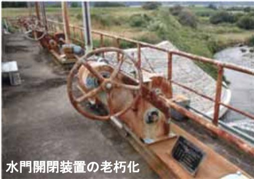
水門開閉装置の老朽化
