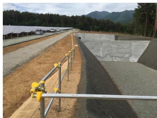
第 1-4-8 図(2) 沈砂池イメージ写真
