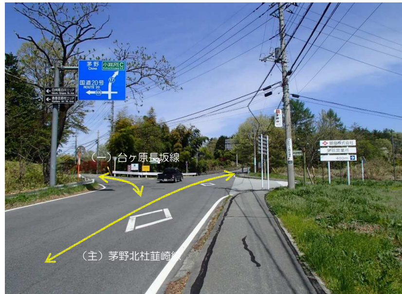
【写真①】 現道の状況 (交差点1)
