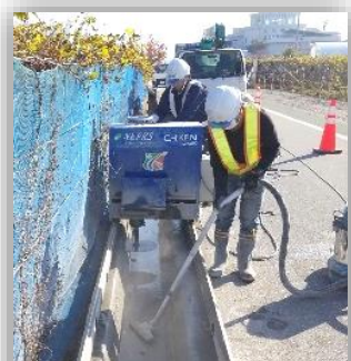
側溝上部改修工
