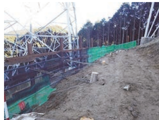
土留めシガラ
