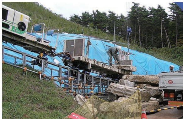
資材運搬（モノレール）
