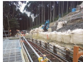
掘削土仮置き
