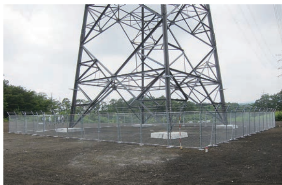
鉄塔フェンス
