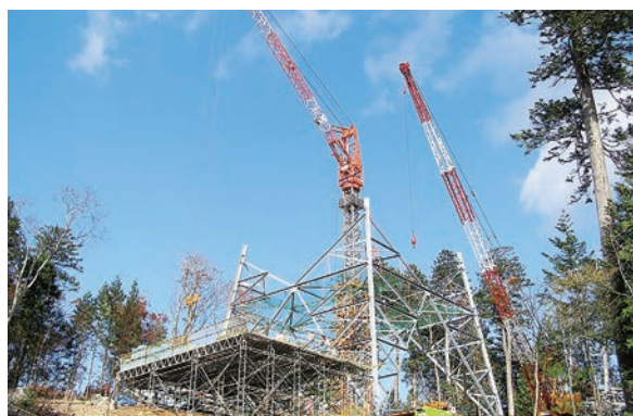
鉄塔組立（クライミングクレーン）
