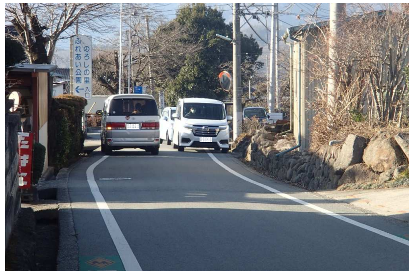
自動車のすれ違いが困難な状況
