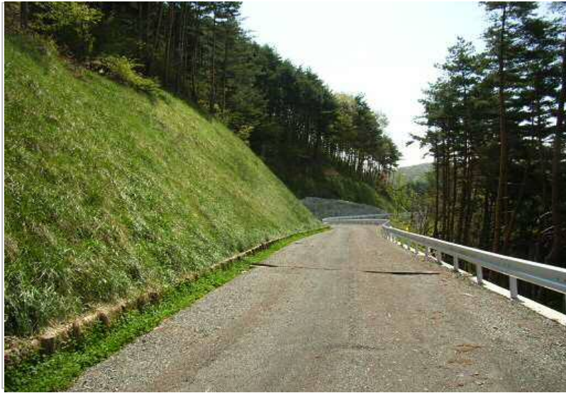
①林道の開設状況
