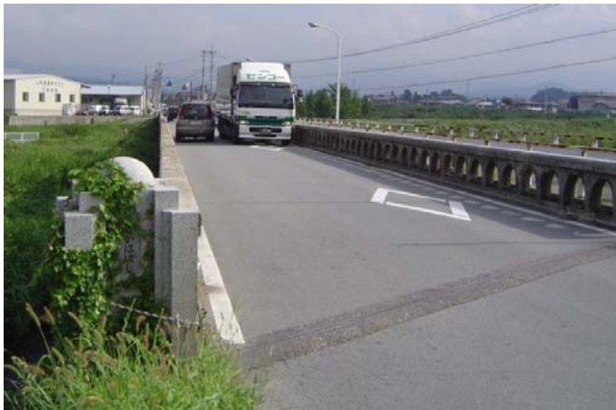
整備前 大型車通行状況
